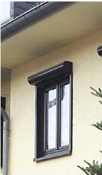
Bild 9: Montage unter Dachvorsprung
