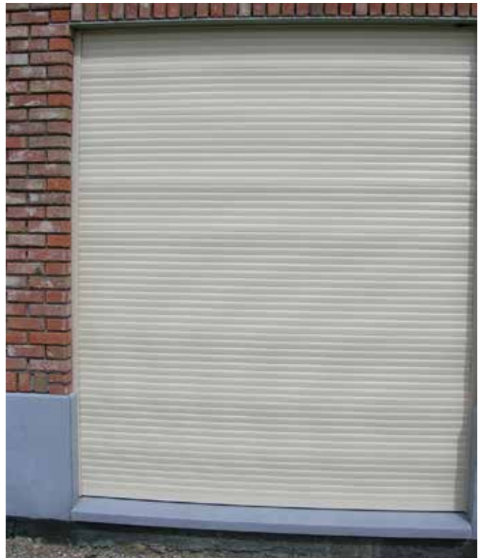
Bild 4: Welligkeit von Rollladenpanzern
